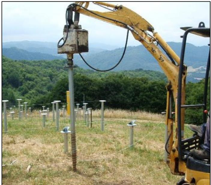
**Figura 3: Sistema di ancoraggio al suolo denominato " T-Block"**
