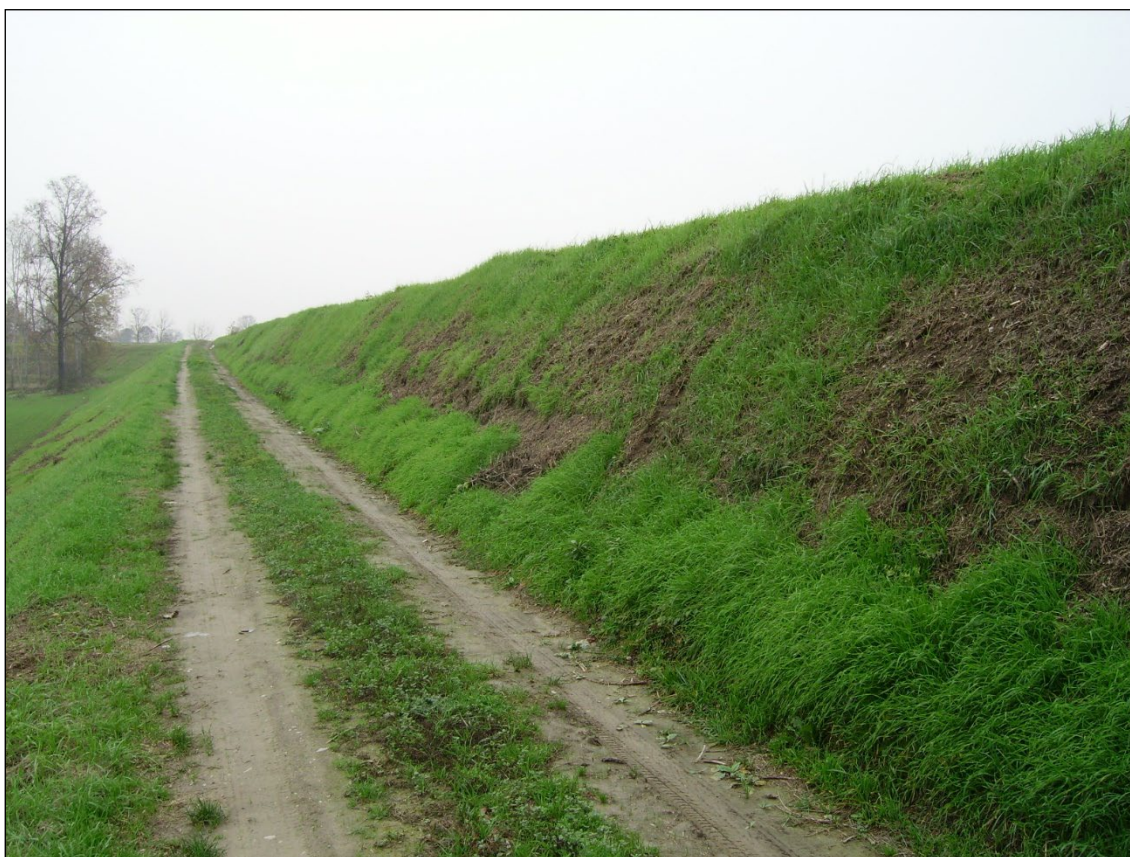
Figura 6 - Strada sterrata d'accesso esistente
