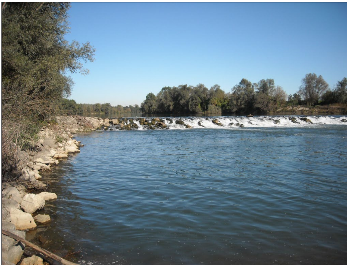
Figura 2 - Panoramica da valle della zona d'intervento
