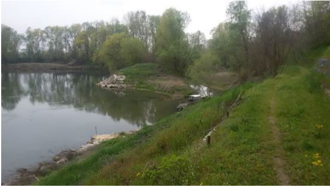
Figura 162. Il tratto basso di scarpata fluviale nei pressi di Crotta d'Adda interessato da interventi antiersivi nei pressi della confluenza della Roggia Ferrarola (la porzione basale sarà parzialmente sommersa dal rigurgito della centrale)
