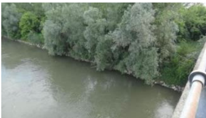
Figura 168 - sponda destra dal ponte stradale delle SSPP 196/47
