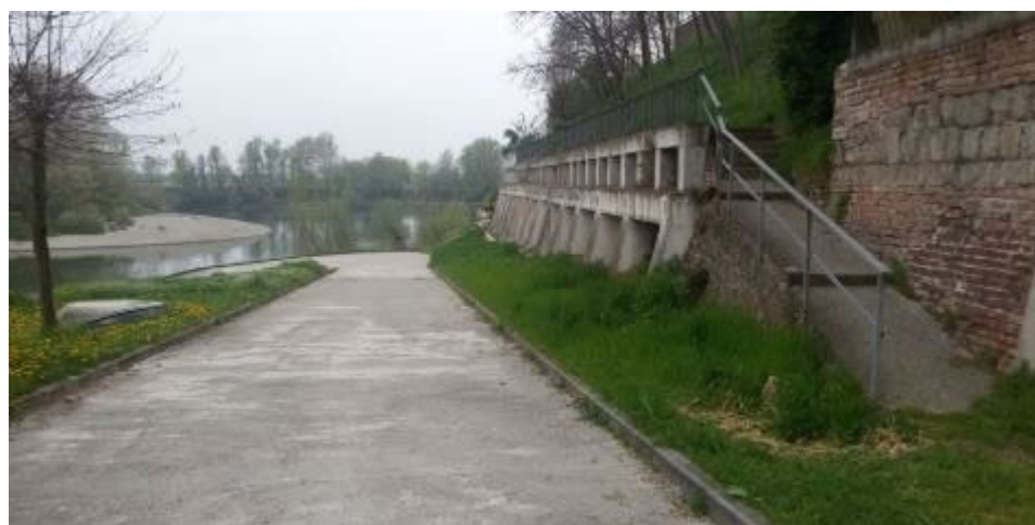
Figura 161: La scarpata di Crotta d'Adda con gli interventi di stabilizzazione (non interessati dal rigurgito generato dalla centrale in progetto).
