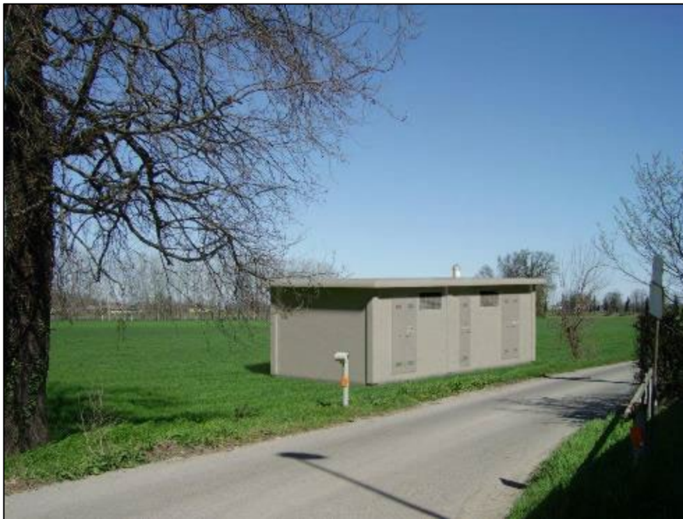
Figura 4: Foto inserimento della nuova cabina elettrica
