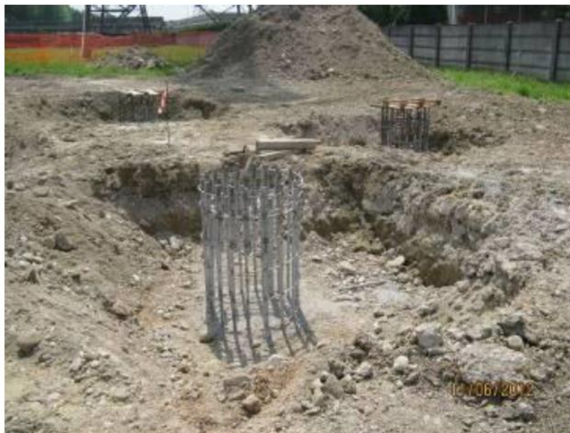
Esempio di realizzazione di una fondazione su pali trivellati.
