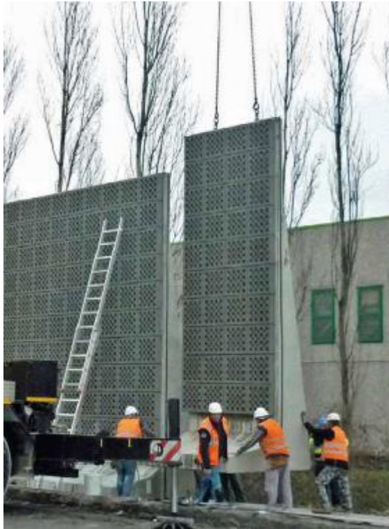
Figura 7 - Esempio di barriere mobili e Spettro di assorbimento barriere mobili
