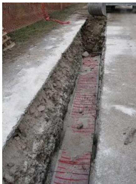
Figura 4.4.25 – Rinterro con posa delle piastre di protezione e rete PVC
