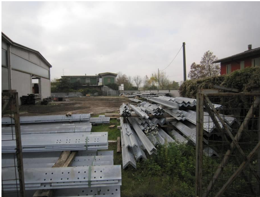
Figura 4.4.5 - Area centrale o Cantiere base – Deposito materiale
