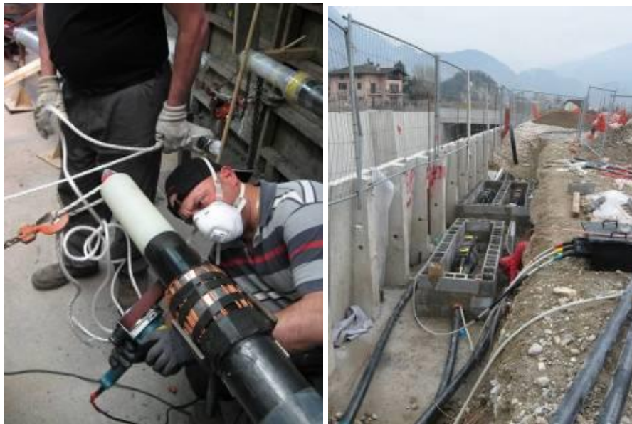
Figura 4.4.24 – Esecuzione giunto – esempio di buca giunti
