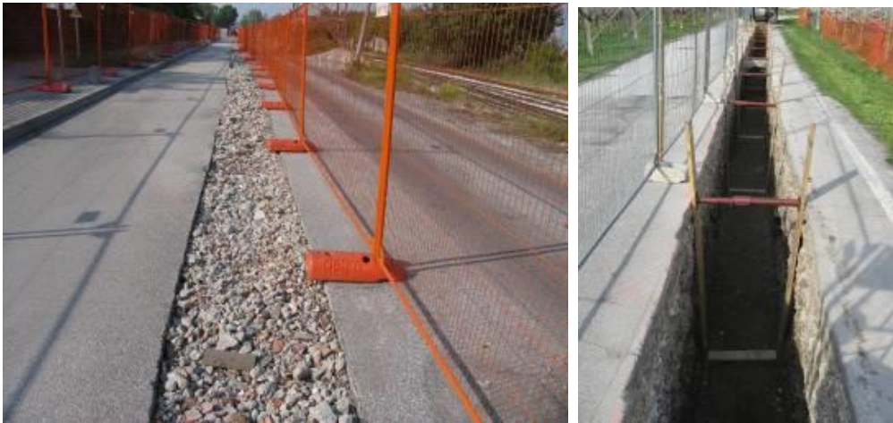
Figura 4.4.22 – Taglio dell'asfaltatura e scavo aperto
