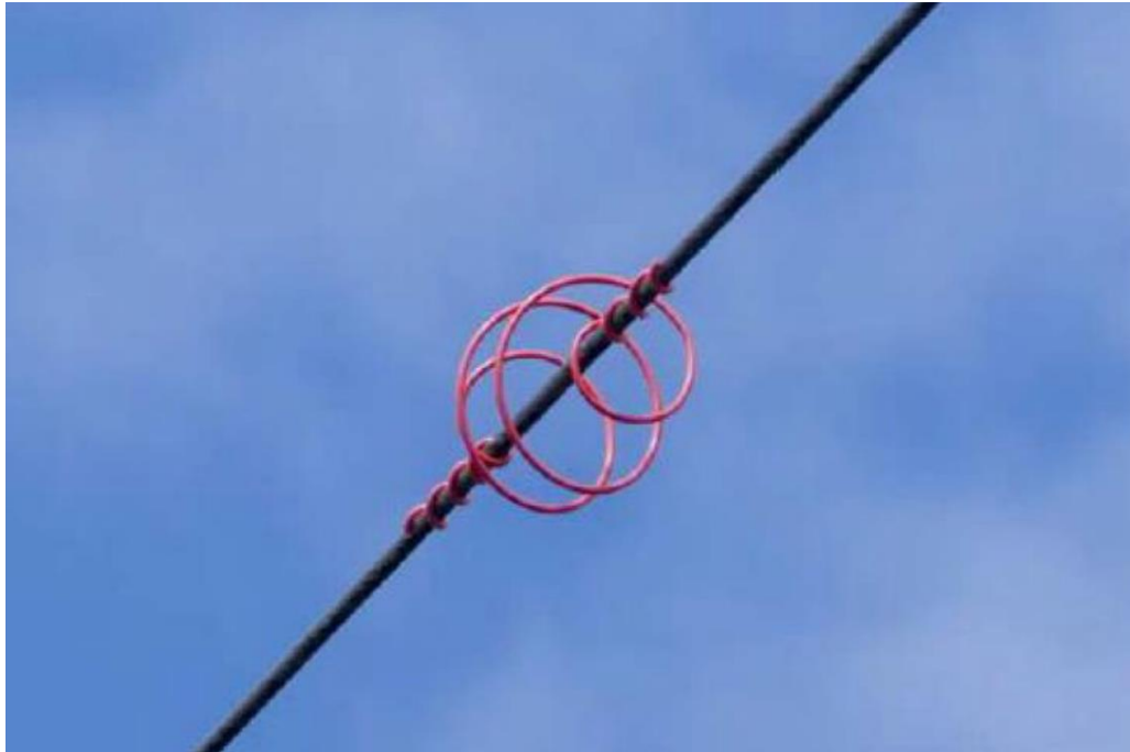
Figura 4.6.1: Esempio di dissuasori
