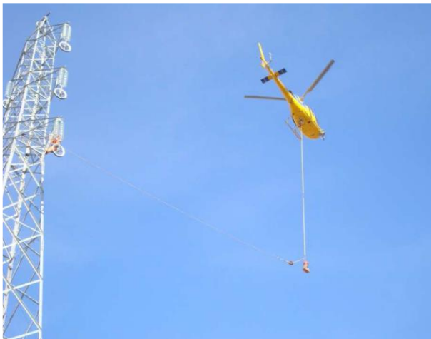
Figura 4.4.17 - Utilizzo dell'elicottero per la stesura della fune pilota
