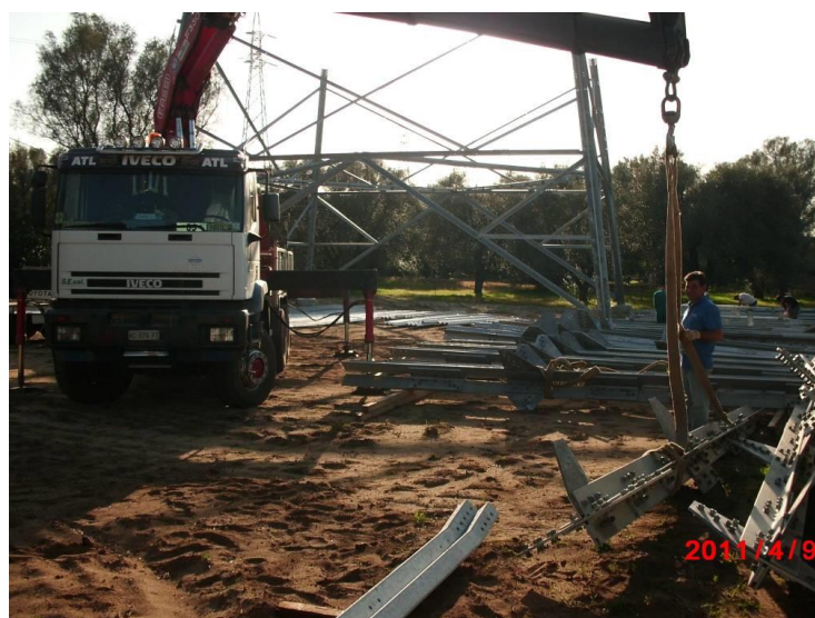
Figura 4.4.10 – Fasi di montaggio sostegno a traliccio
