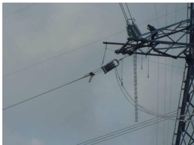
Figura 4.4.18 – Fasi di tesatura della linea elettrica
