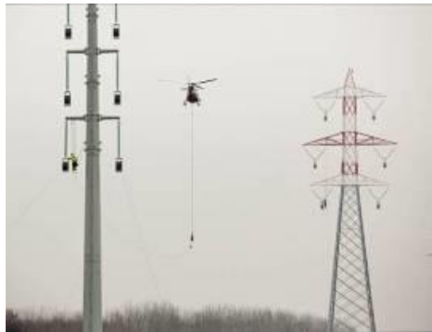
Figura 4.4.17 - Utilizzo dell'elicottero per la stesura della fune pilota
