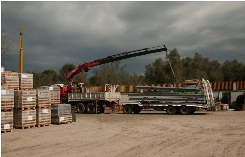
Figura 4.4.7 - Area centrale o Cantiere base
