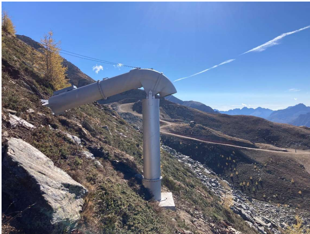
Foto 11.4 – Esploditore tipo Gaz-ex da 3 m 3 in condizioni estive.
