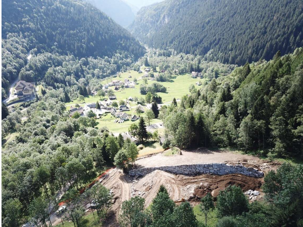
Foto 11.6 – Rilevato deviatore in scogliera in fase di realizzazione.
