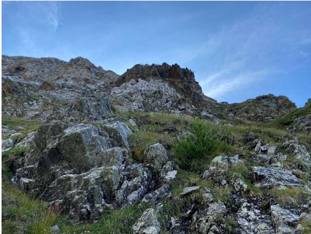
Foto 8.3 -Vista del settore a monte del sostegno "CP 75".
