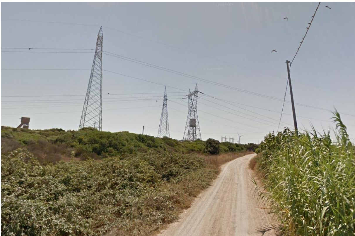
Figura 4-5. Interferenza con rete elettrica in Bassa tensione su palo (BT_054) e in Alta tensione su traliccio (AT_006, AT_007, AT_008)
