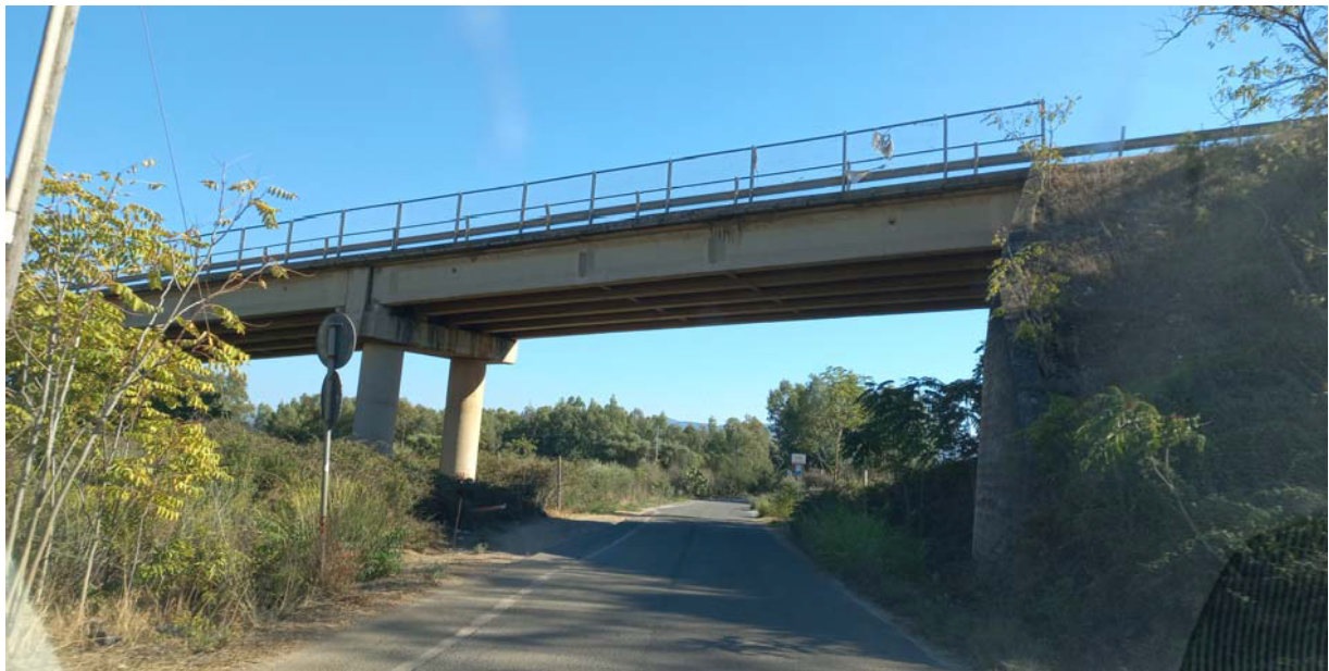
Immagine 41 – Via Barega (cavalcavia di altezza utile 8,20 metri)
