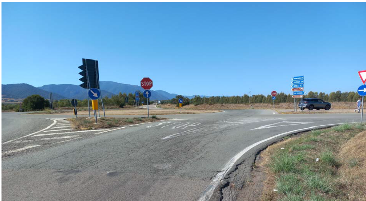
Immagine 32 – Strada Provinciale 2 (incrocio con Strada Statale 293) Coordinate 39°16'16.31"N - 8°48'53.76"E
