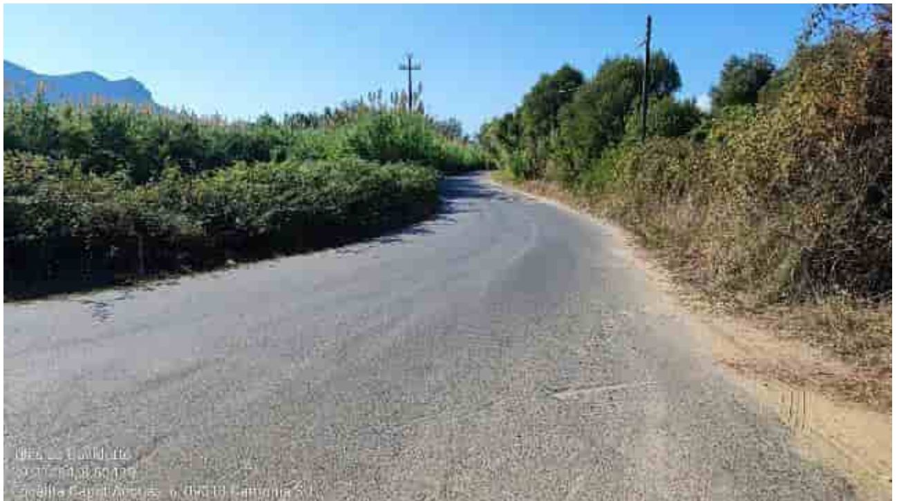
Carbonia, loc. Caput Acque: porzione stradale interessata dal tracciato del cavidotto.
