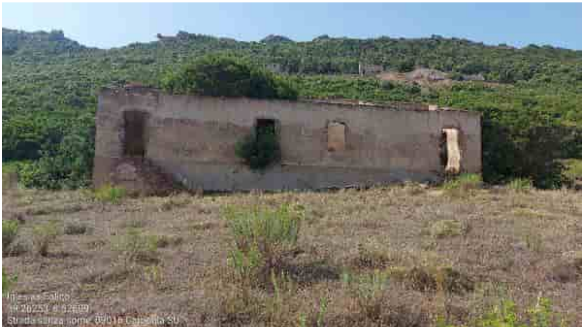
Iglesias, loc. s.n.: ruderi di edifici presenti nelle vicinanze dell'area interessata dall'opera in progetto.
