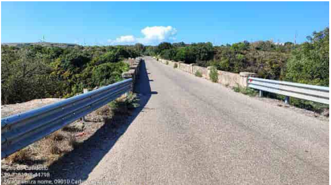
Carbonia: ponte sul Rio S'Acqua Sa Stoia interessato dal tracciato del cavidotto.
