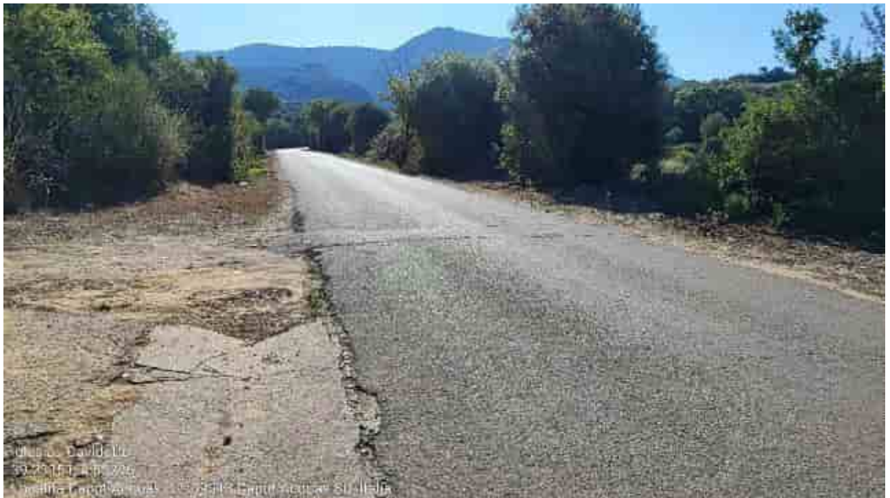
Carbonia, loc. a est di Caput Acque: porzione stradale interessata dal tracciato del cavidotto.
