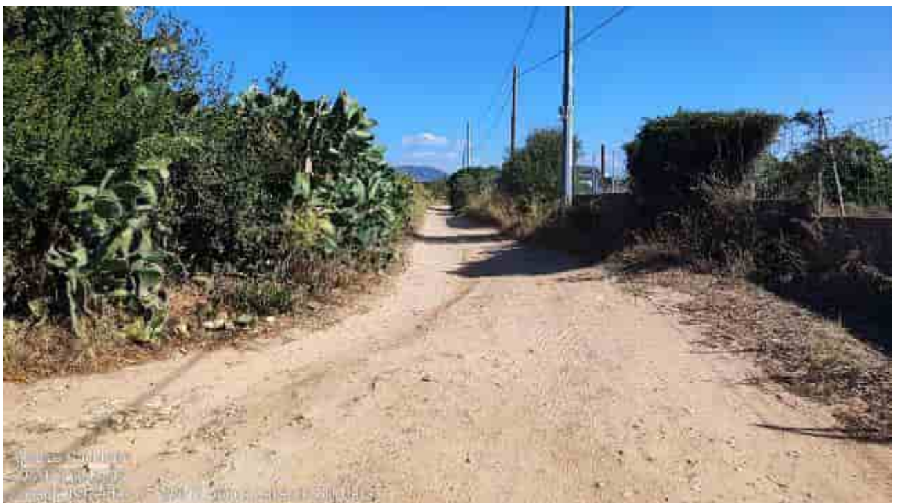
Carbonia, loc. a sud di Medau de is Perdas: tratto stradale interessato dal tracciato del cavidotto.
