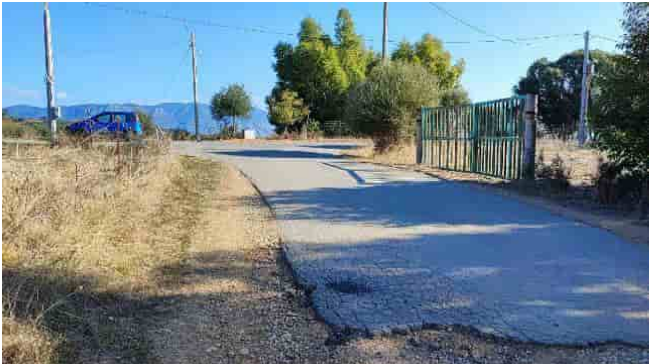
Carbonia, loc. a nord di Barga: porzione stradale interessata dal tracciato del cavidotto.
