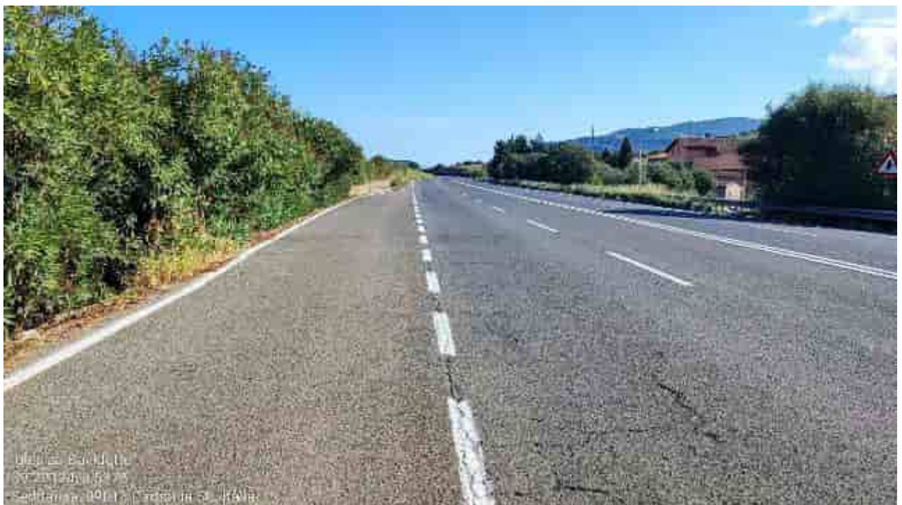
Carbonia, loc. Medau Piredda: porzione di Strada Provinciale 2, via Pedemontana, interessata dal tracciato del cavidotto.
