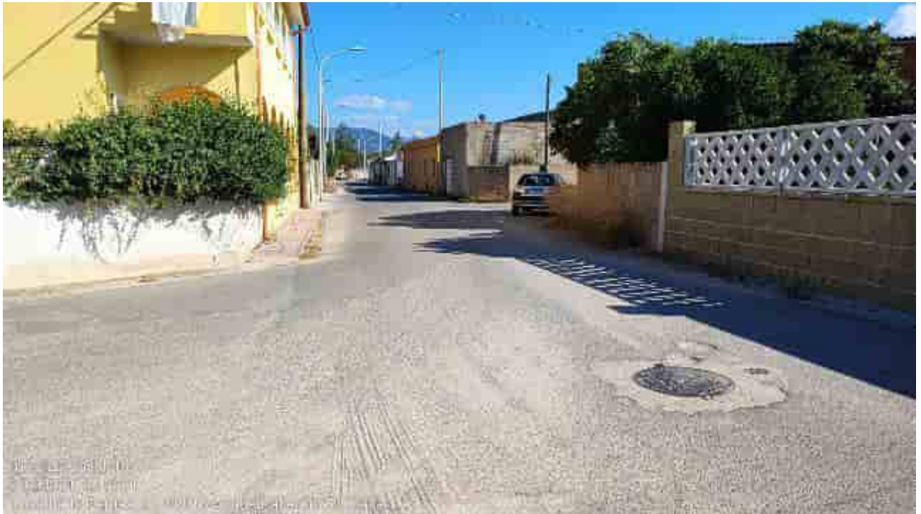
Carbonia, loc. a sud di Medau de is Perdass: tratto stradale interessato dal tracciato del cavidotto.
