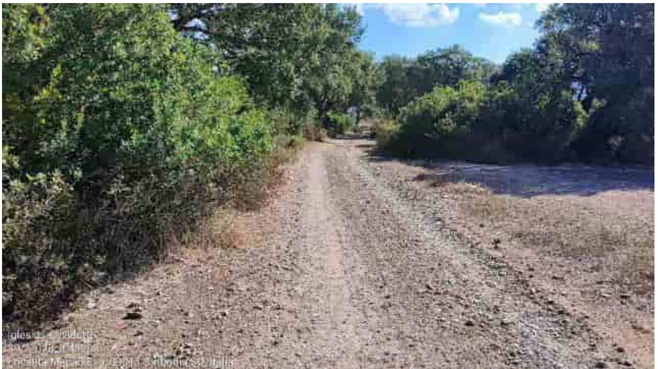
Carbonia, loc. a sud est di Mesu Pranu: tratto stradale in sterrato interessato dal tracciato del cavidotto.
