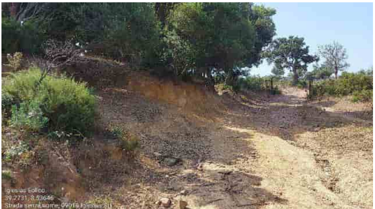
Iglesias, loc. Rio Crocconghessa: sezioni esposte lungo il tracciato del cavidotto in progetto.
