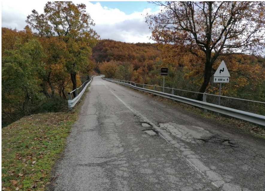
PARTICOLARE DEL PONTE SUL TORRENTE CASALE
