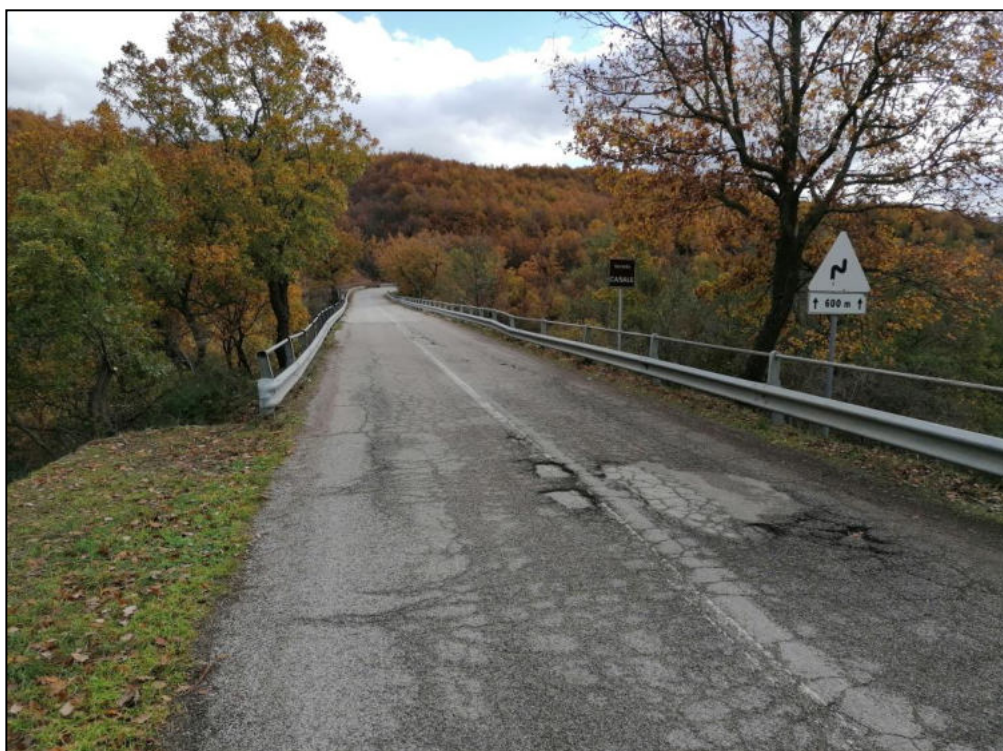
PARTICOLARE DEL PONTE SUL TORRENTE CASALE
