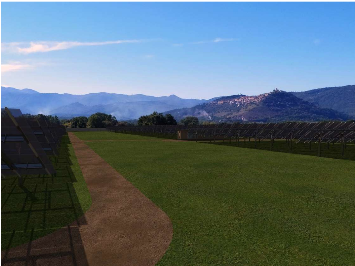
Foto 5 – Vista interna impianto Grumento 2
