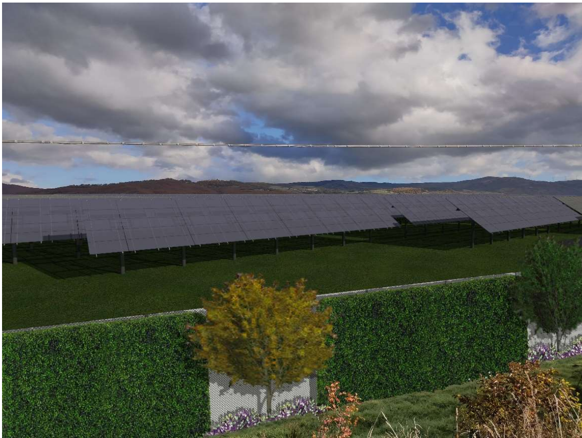
Foto 1 – Vista lato sud
