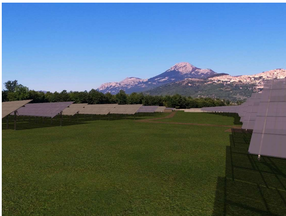
Foto 4 – Vista interna impianto Grumento 1
