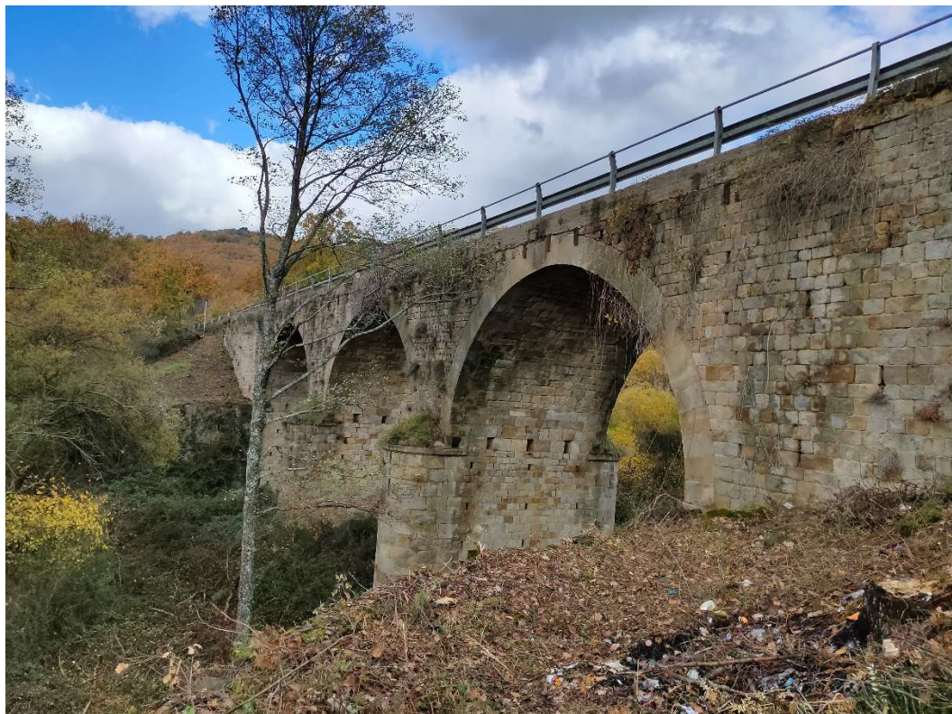
Foto 8 - Vista attraversamento torrente Casale
