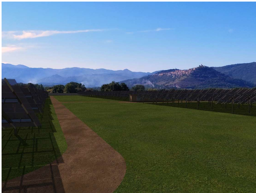
Foto 5 – Vista interna impianto Grumento 2
