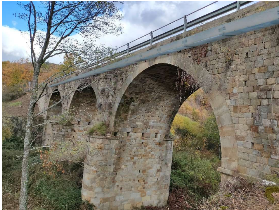
Foto 7 – Vista attraversamento torrente Casale
