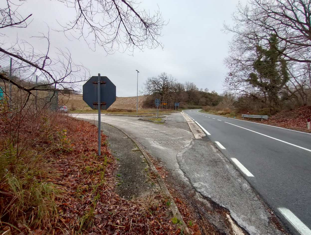
Figura 10 - Vista dell'area che ospiterà la rotonda di fine tracciato ad Est
