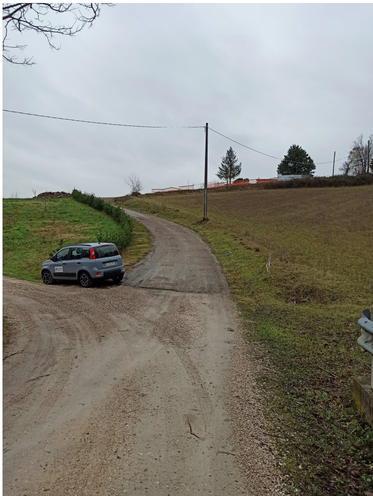
Figura 6 - Area di sbancamento inizio galleria artificiale
