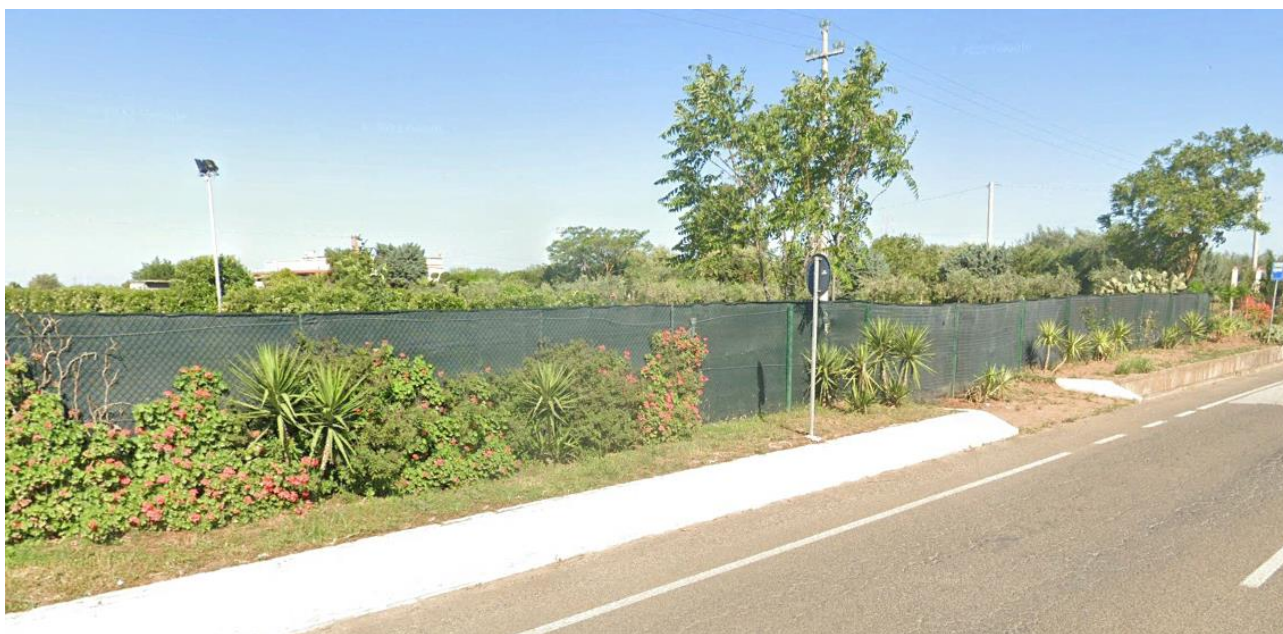
Figura 6-7: Vista 3 dalla S.S. 580 (fonte Google Earth Pro)
