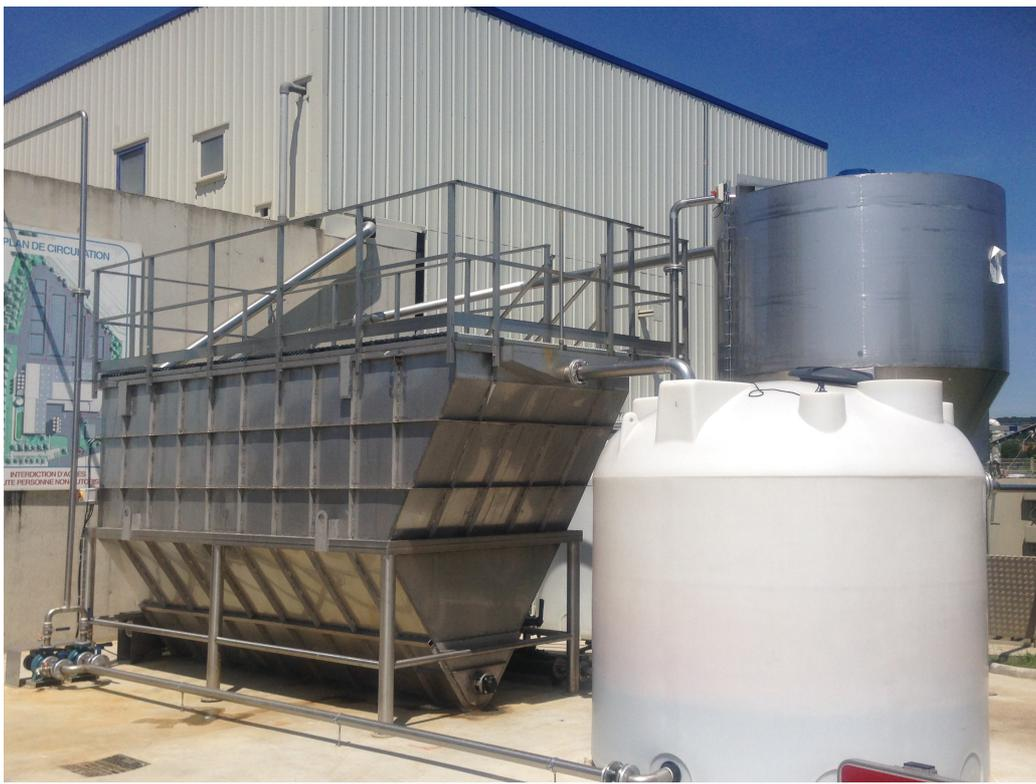
**PSFB1-2 N° 2 pompe centrifughe** per estrazione fanghi con girante vortex, corpo pompa e girante realizzato in ghisa, portata 60 mc/h a mt 5 motore a secco Kw 3,0.
