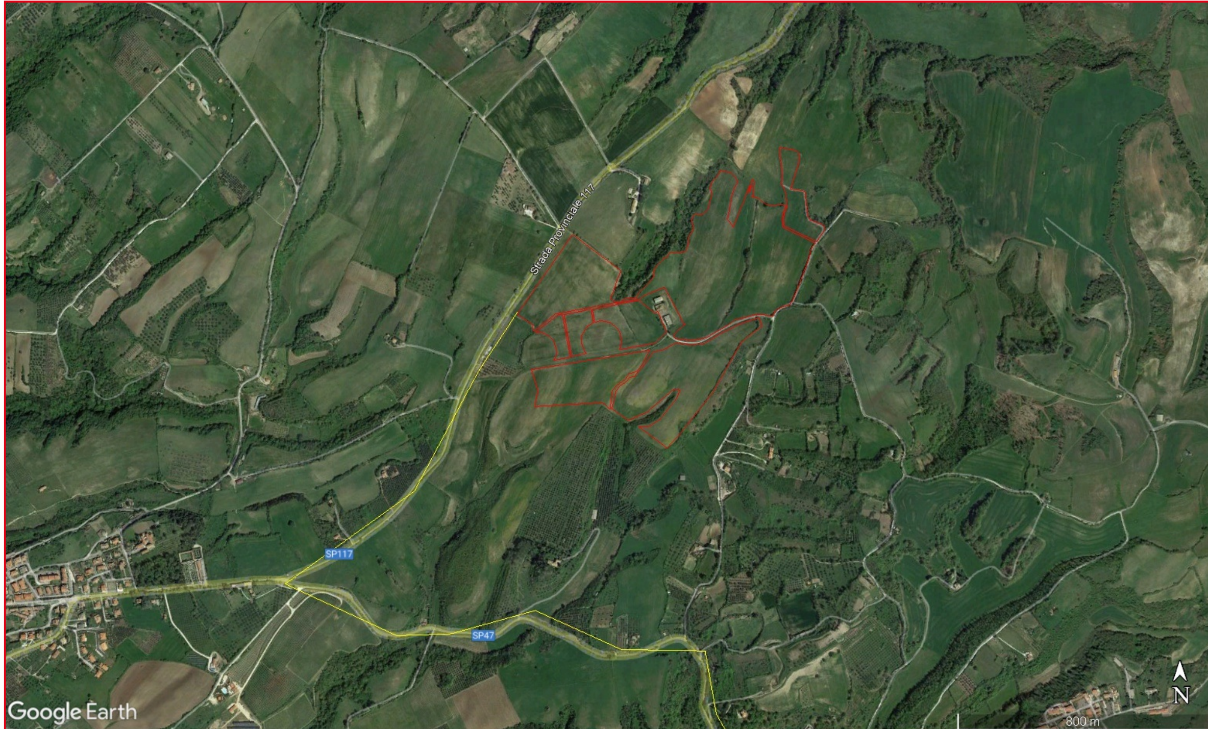
Fig. 1 - In rosso i lotti di terreno interessati dall'installazione dell'impianto agrivoltaico (da Google Earth).
