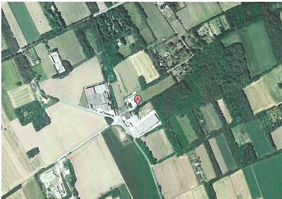
Figura 9.7 –Ecoter impianto di lavorazione (Legnano), foto aerea (in rosso l'area di interesse)
