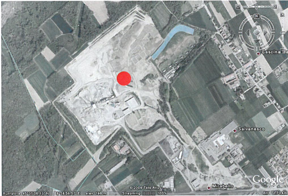
Figura 6.9 – Cava Fusi impianto di lavorazione (Malpaga), foto aerea (in rosso l'area di interesse)
