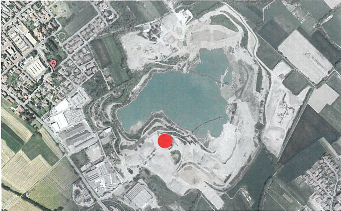
Figura 9.5 –Ecoter impianto di lavorazione (Nerviano), foto aerea (in rosso l'area di interesse)
