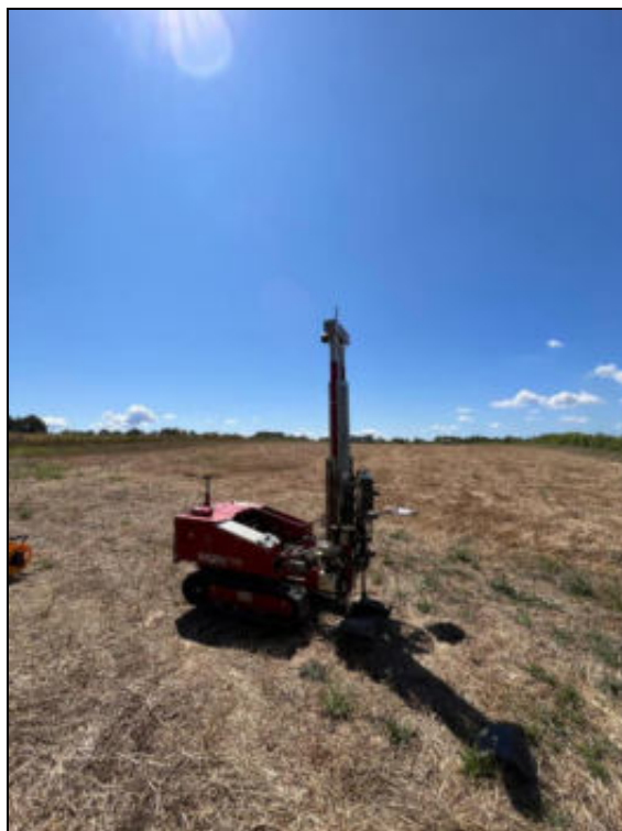
Foto 3: Esecuzione prova penetrometrica DPSH2 – Sito PI02
