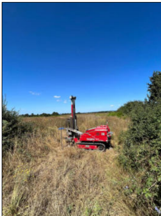
Foto 1: Esecuzione prova penetrometrica DPSH1 – Sito PI03
