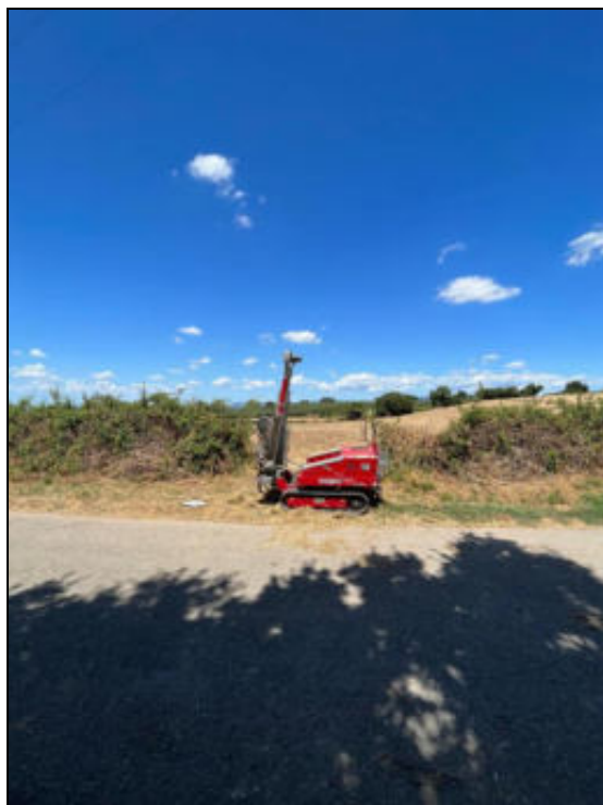
Foto 5: Esecuzione prova penetrometrica DPSH3 – Sito PI04
