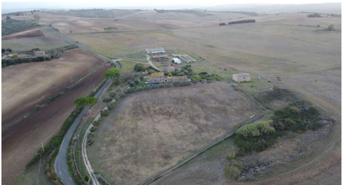
Figura 15: immagine da drone raffigurante il paesaggio dell'area dell'impianto fotovoltaico, visione da ovest.
