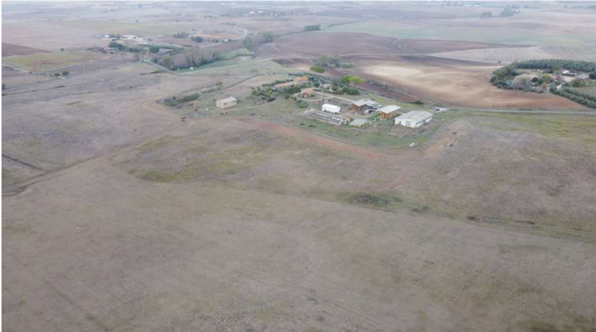
Figura 14: immagine da drone raffigurante il settore centrale dell'area dell'impianto fotovoltaico.
