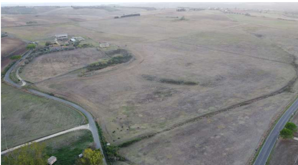
Figura 13: immagine da drone raffigurante il paesaggio nell'area dell'impianto fotovoltaico, visione da ovest.
