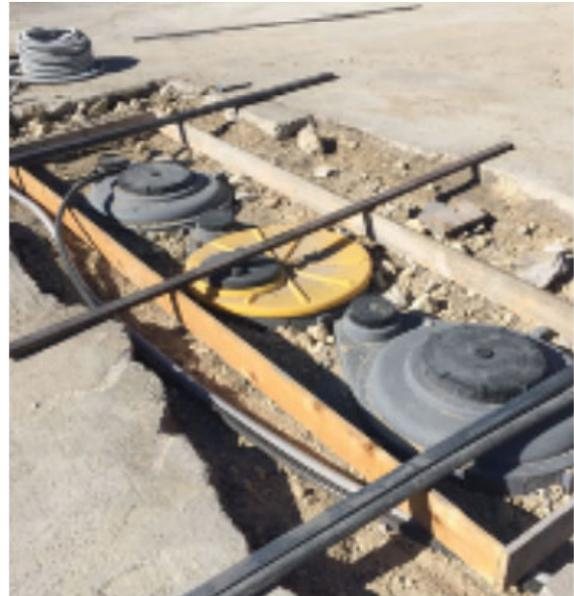
Figura 27: esempio di installazione dei serbatoi a tenuta
