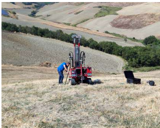
FOTO 5 - ESECUZIONE PROVA DPSH 5
