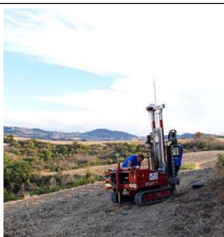
FOTO 8 - ESECUZIONE PROVA DPSH 8
