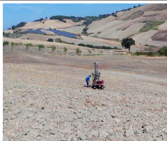
FOTO 2 - ESECUZIONE PROVA DPSH 2
