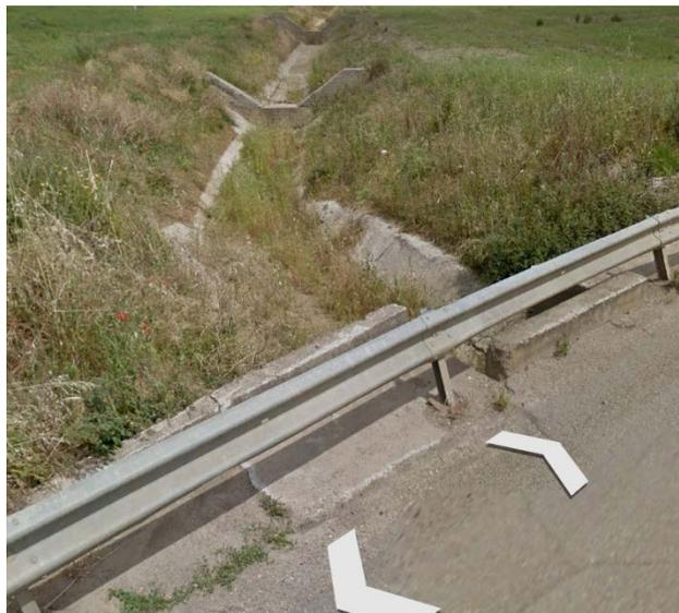
Trattandosi di un canale completamente cementato non si ha rischio di erosione del fondo da parte delle acque di ruscellamento.
