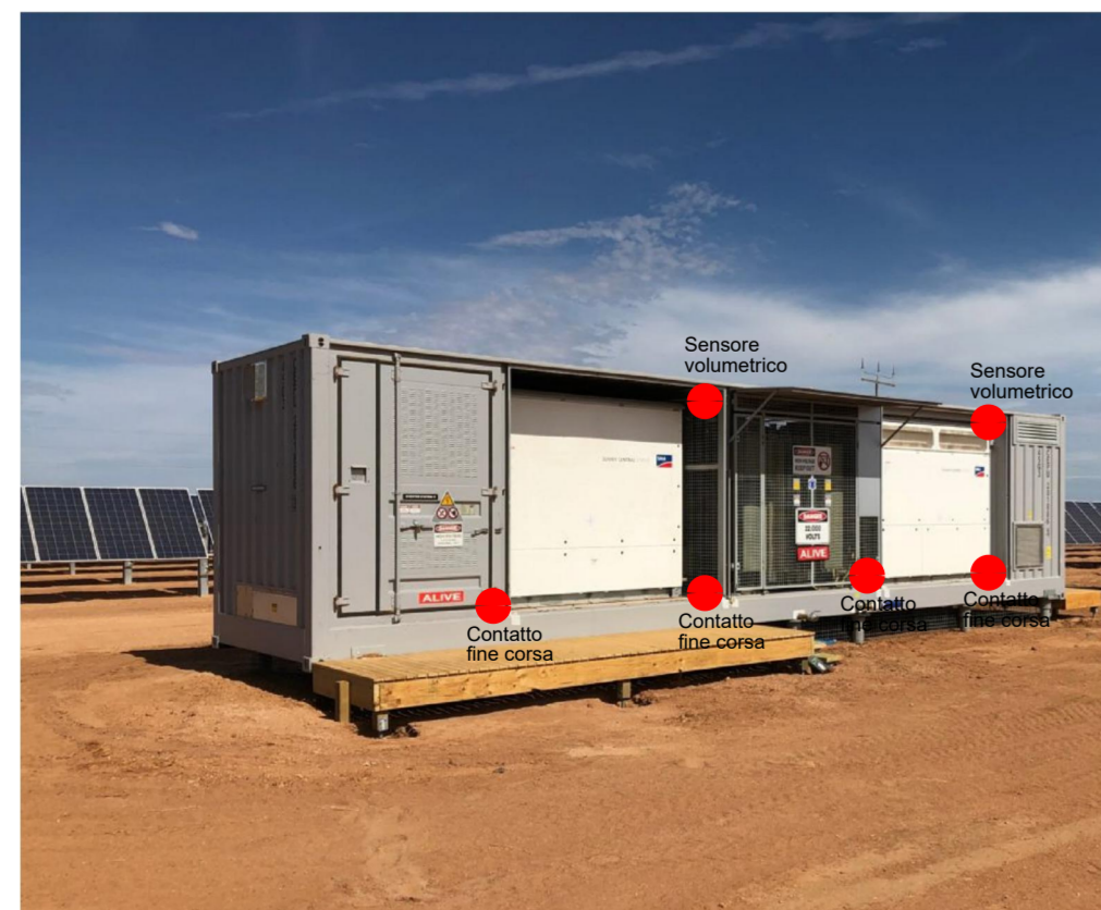
CONTROLLO ACCESSO CABINET (sensori volumetrici e contatti porta)
