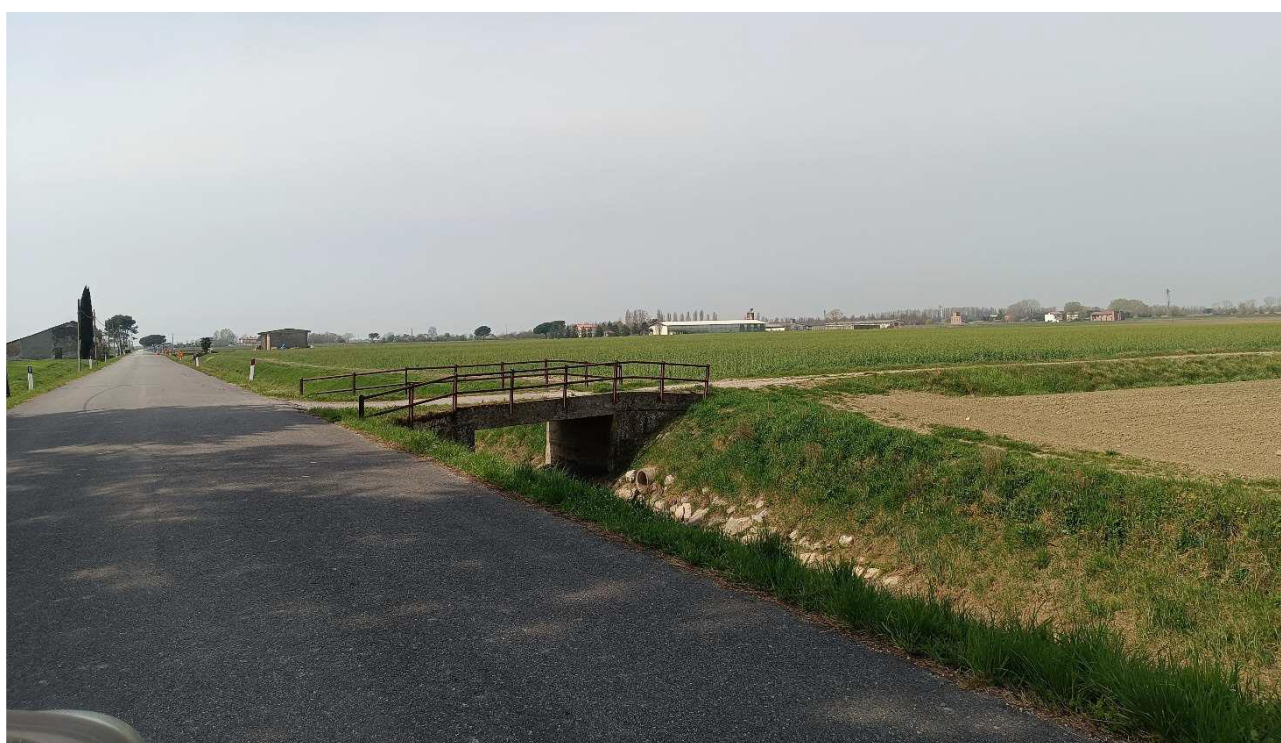
Figura 3.6: Accesso sottocampo 2 e stazioni elettriche da est
