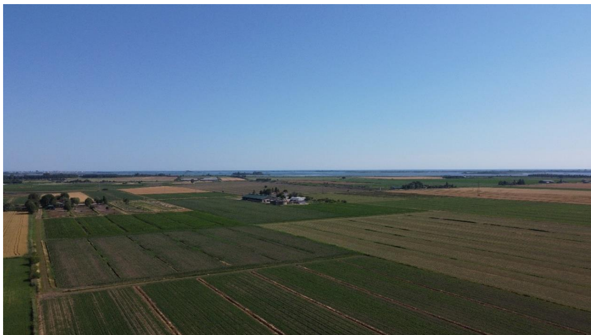
Vista dell'area a volo d'uccello da Nord-Est (Cono 6)
