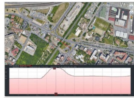
Come si può vedere la linea ferroviaria nell'area prevista per la realizzazione della nuova stazione ferroviaria corre su di un rilevato dell'altezza approssimativa di 7 m.
