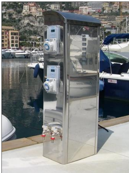
Figura 3.12 – Raffigurazione delle colonnine degli attacchi agli impianti
