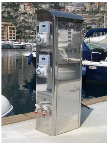
Figura 3.10 – Raffigurazione delle colonnine degli attacchi agli impianti
