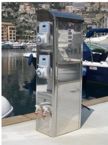
Figura 4.11 – Raffigurazione delle colonnine degli attacchi agli impianti
