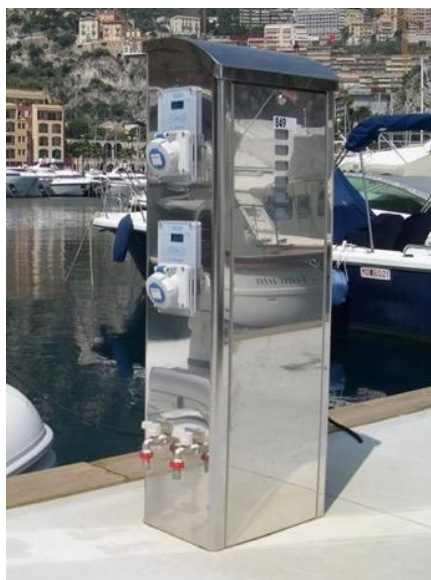
Figura 3.22 – Raffigurazione delle colonnine degli attacchi agli impianti
