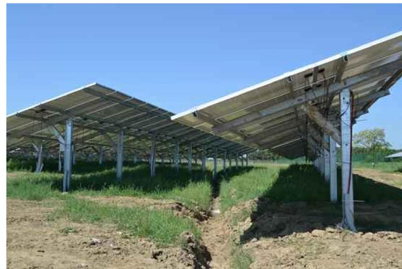
Esempio di struttura - Tipo fisso
