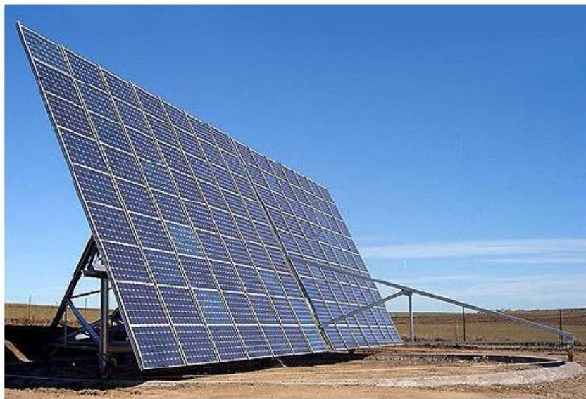
*Figura 3.2-2 Inseguitori Azimut- elevazione*
