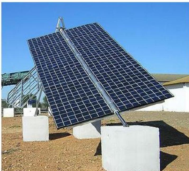
*Figura 3.1-5 Inseguitori ad asse polare*
