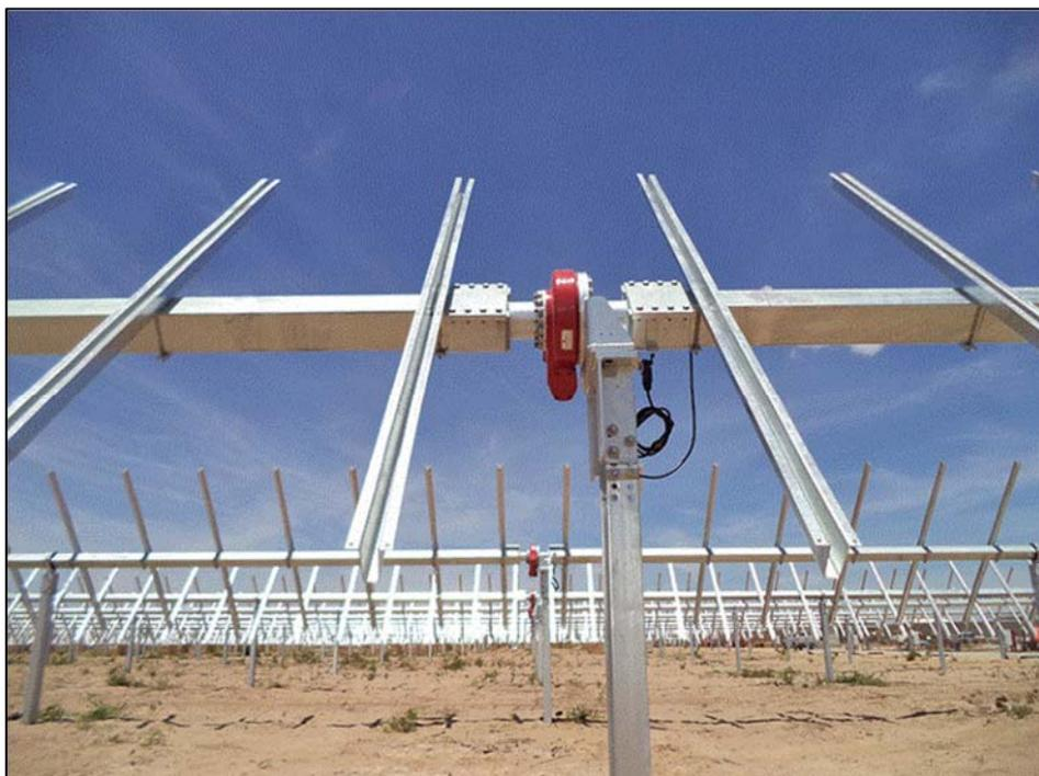
Figura 59 - Componenti struttura di supporto
