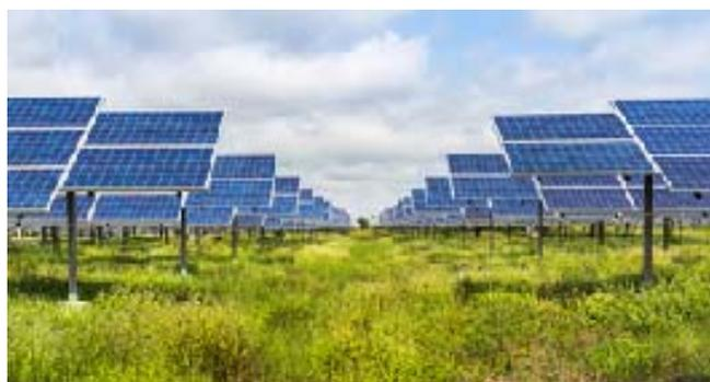
Foto 10- Impianto fotovoltaico con pannelli ad inseguimento
