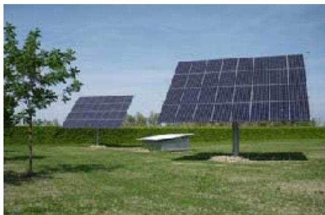
Foto 9 - Impianto fotovoltaico con pannelli ad inseguimento
