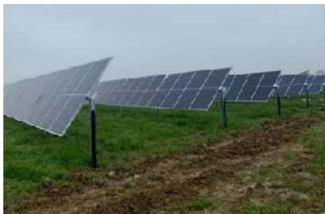
Foto 8 - Impianto fotovoltaico con pannelli ad inseguimento
