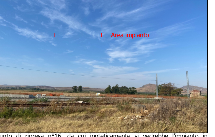
Punto di ripresa n°16, da cui ipoteticamente si vedrebbe l'impianto in assenza di ostacoli, posto a 75 m.s.l.m. e distante circa 6025 m dall'area di impianto. La foto è stata eseguita dalla strada SS192 nei pressi dell'area di progetto con un angolo di scatto di circa 130°.
