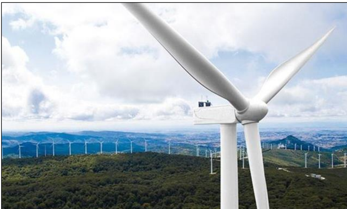
Figura 25 – Esempio di installazione di turbina eolica
