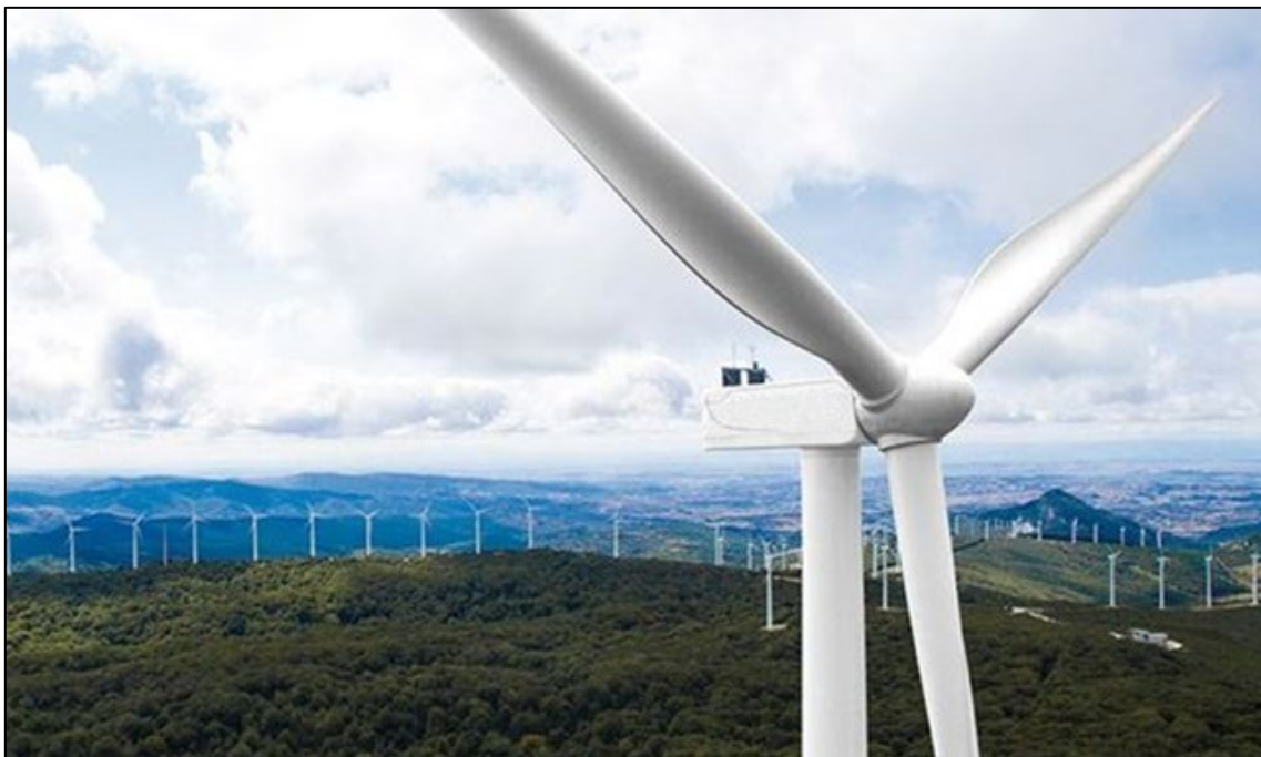
Figura 3 – Esempio di installazione di turbina eolica
