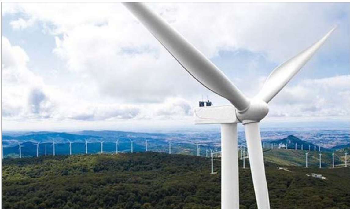
Figura 3 – Esempio di installazione di turbina eolica
