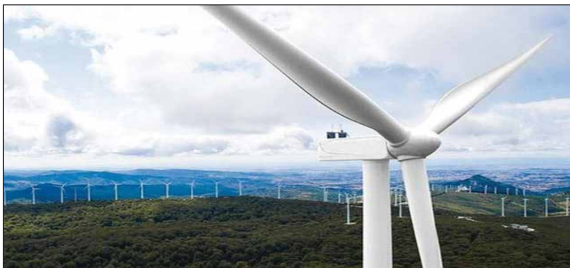
Figura 15 – Esempio di installazione di turbina eolica
