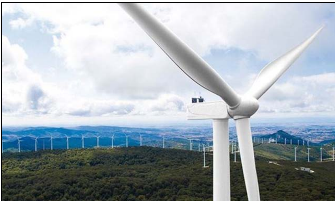
Figura 3 – Esempio di installazione di turbina eolica
