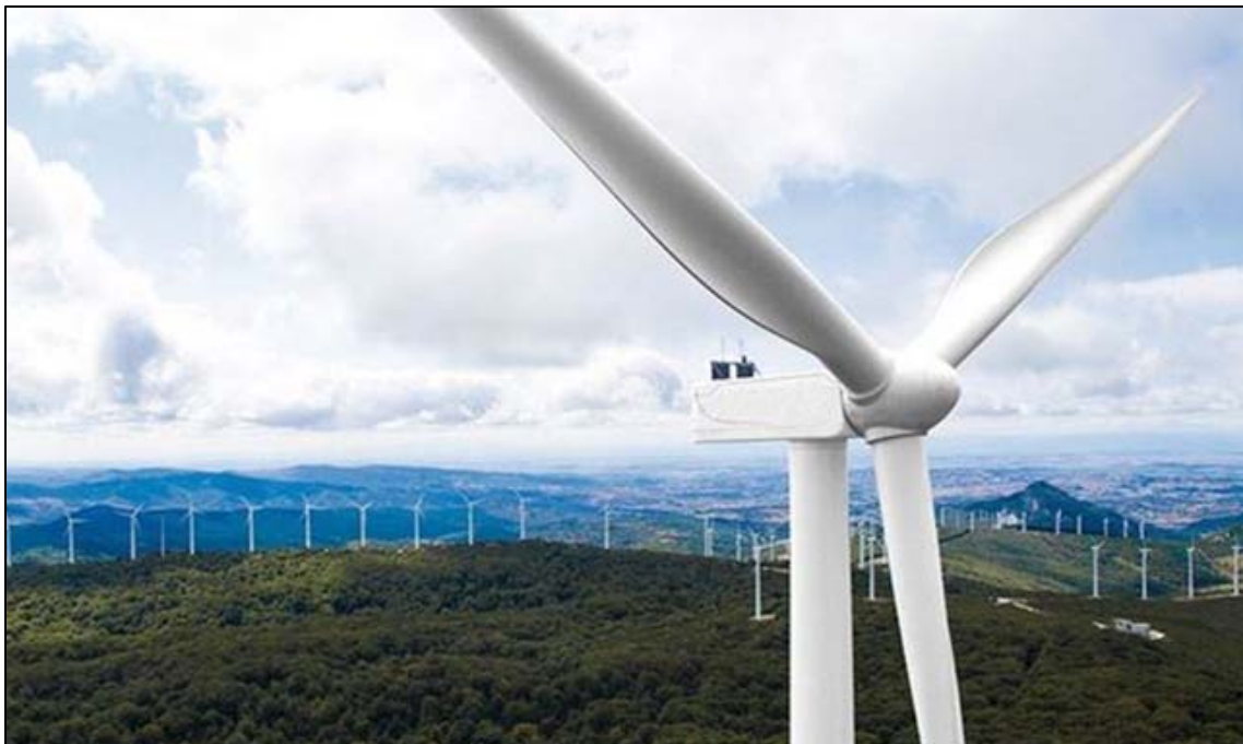
Figura 4 – Esempio di installazione di turbina eolica
