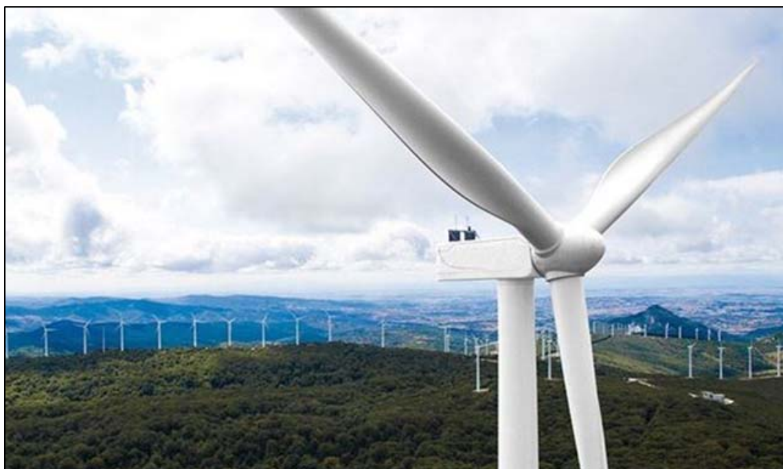
Figura 3 – Esempio di installazione di turbina eolica
