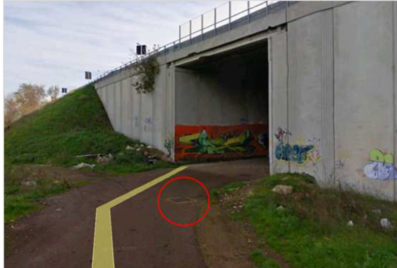
Es. interferenza interrata al km 0+123 della Viabilità di ricucitura n. 2 – Linea dati in fibra ottica
