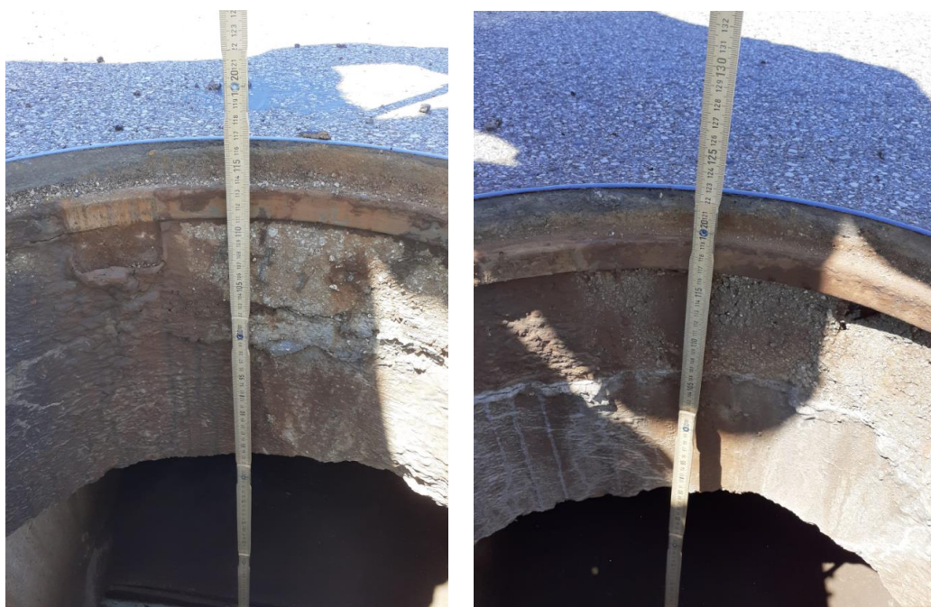
Figura 2 - Quote pozzetti P1 e P2
