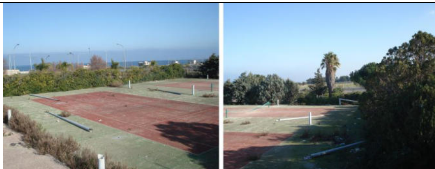
Figura 79 Infrastrutture in abbandono.
