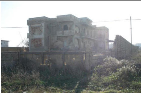
Rudere : Via Giovanni di Cagno Abbrescia
