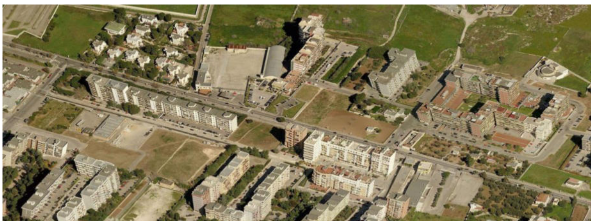
Figura 76 Le espansioni residenziali recenti realizzate con grandi volumetrie in edifici multipiano.
