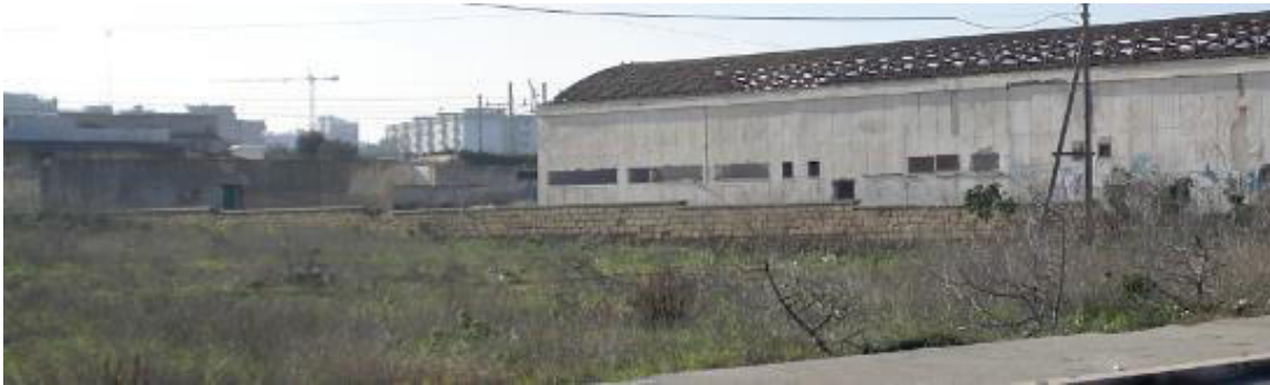
Figura 96. Area cantiere Base/operativo. A lato Capannone abbandonato, sullo sfondo gli edifici del quartiere S. Anna.
