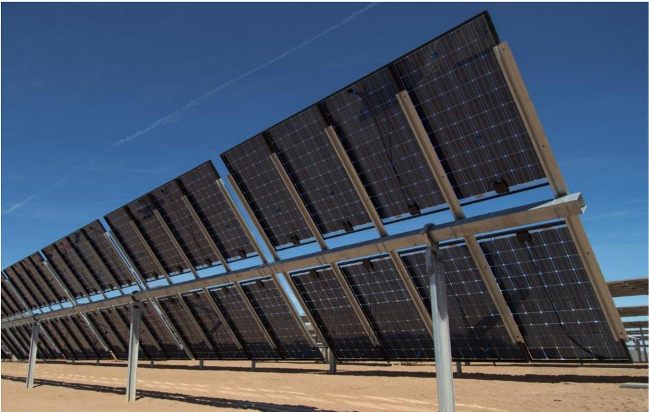
Figura 79: Esempio struttura e modulo FV bifacciale
