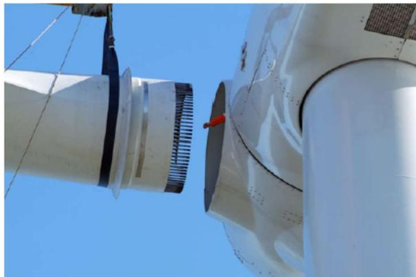
*Fig. 5 Montaggio Pala*
