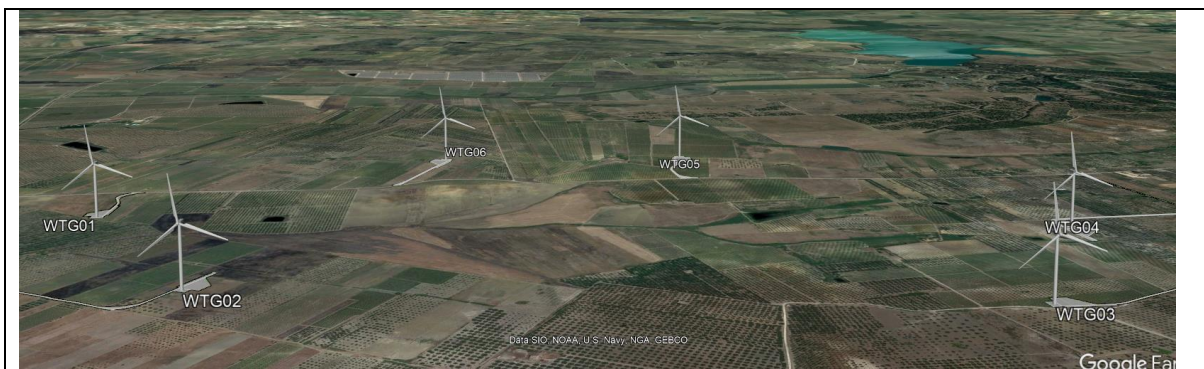
Figura 7 – Vista degli aerogeneratori WTG01, WTG02, WTG03, WTG04, WTG05, WTG06 (inquadratura sud-nord)
