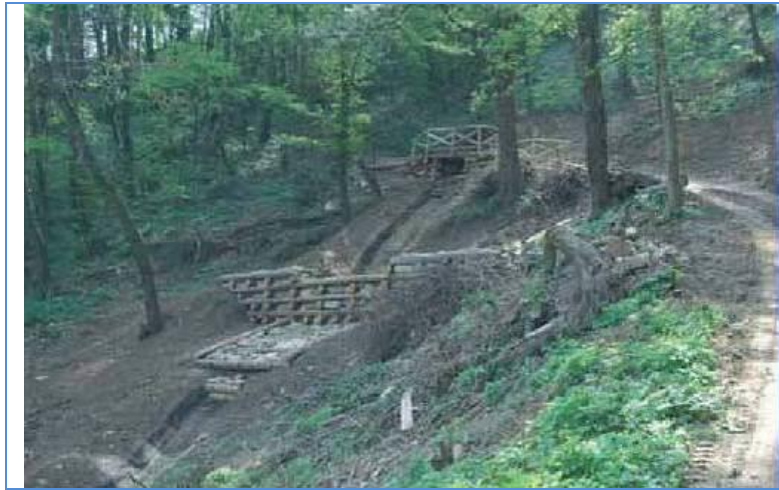
Figura 14 – Esempio di briglie in legname e pietrame - Fonte HE
