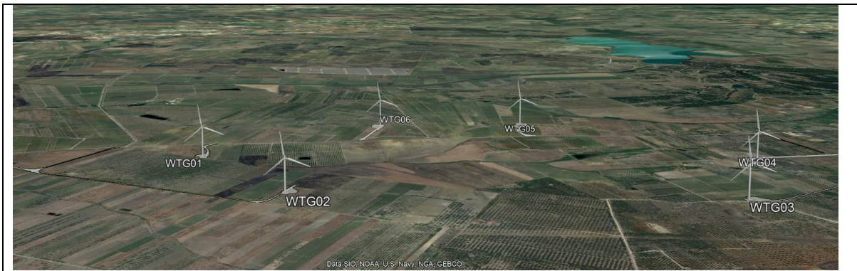
Figura 8 – Vista degli aerogeneratori WTG01, WTG02, WTG03, WTG04, WTG05, WTG06 (inquadratura sud-nord)
