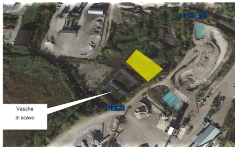
Figura 15 – Vasche limitrofe al tracciato e in giallo l'ubicazione del "sito orfano"
